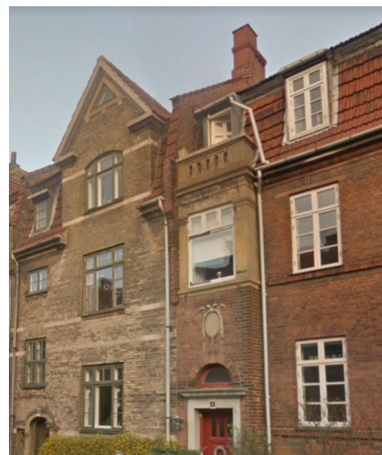
Kalkstenskarnap ved fremspring
