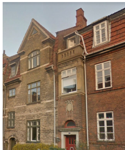
Kalkstenskarnap ved fremspring
