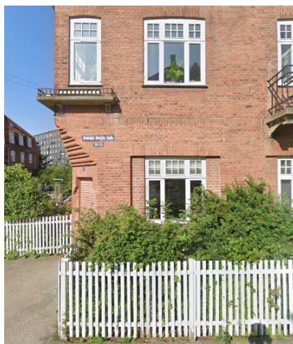
Eksempel på opmuring med reces ved udskiftning af butiksvinduer
