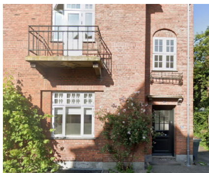
Eksempel på opmuring med reces ved udskiftning af butiksvinduer
