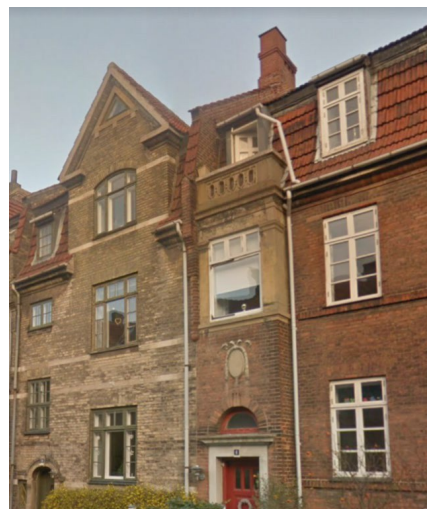
Kalkstenskarnap ved fremspring
