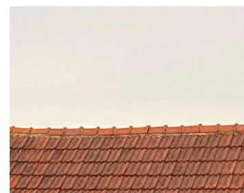
Eksempel på rygningssten lagt i mørtel.
